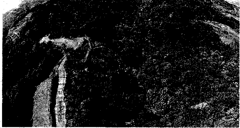
地肌が露出した八国見山での進入道路の工事現場（左側）。工事は6月末まで一時中止に—ネイチャーシネプロ・吉田嗣郎さん提供
