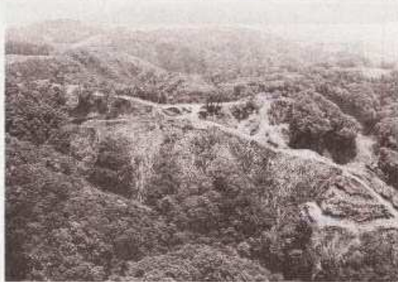
樹林が伐採されるなど開発が進む現場—吉田さん提供
