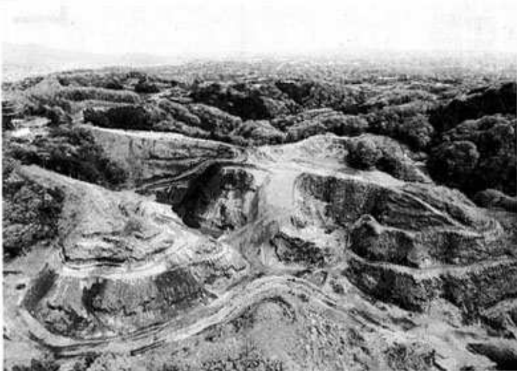
八国見山南面区域で谷の埋め立てが進められる霊園の建設現場—秦野市渋沢で4月(吉田嗣郎さん提供)
